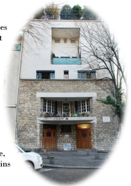
Maison construite en 1926 par Adolf Loos pour Tristan Tzara (15 avenue Junot – Paris XVIIIème)
