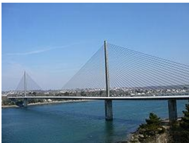
Un pont haubané : le pont de l'Iroise à Brest
