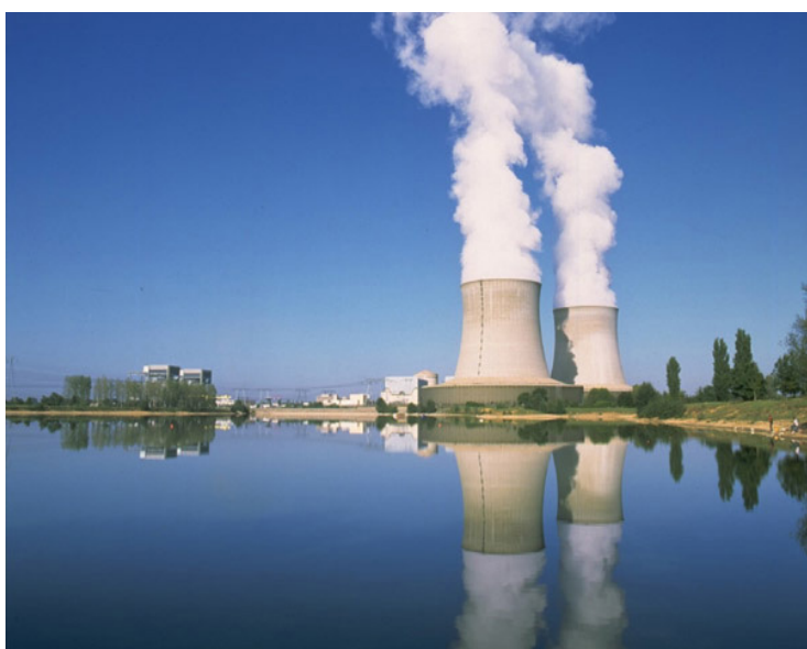
La centrale de Saint-Laurent-des-Eaux
